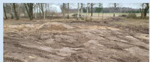
Naujo požeminio vandens gavybos (paėmimo) gręžinio statyba.
