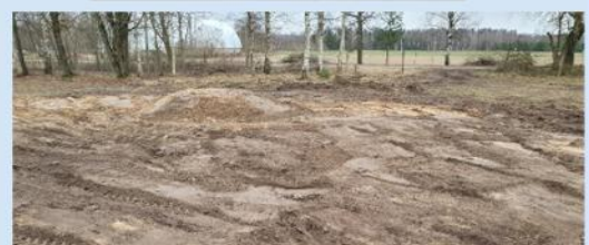
Naujo požeminio vandens gavybos (paėmimo) gręžinio statyba.
